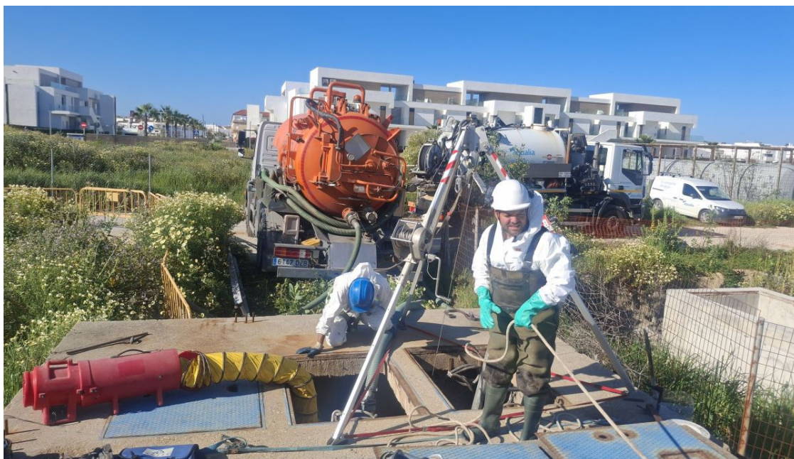
Limpieza de estaciones de bombeo en Barbate y Zahara de los Atunes.
